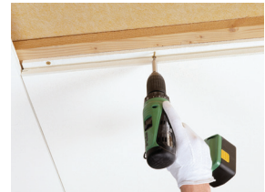
Монтаж Master F с помощью саморезов
